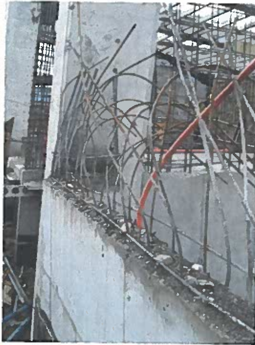
Fotografía 7 Armadura de muro
