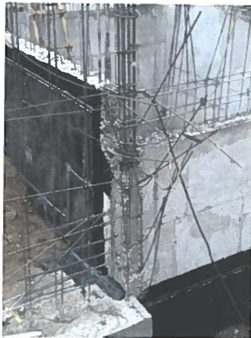
Fotografía 6 Armadura de muro
