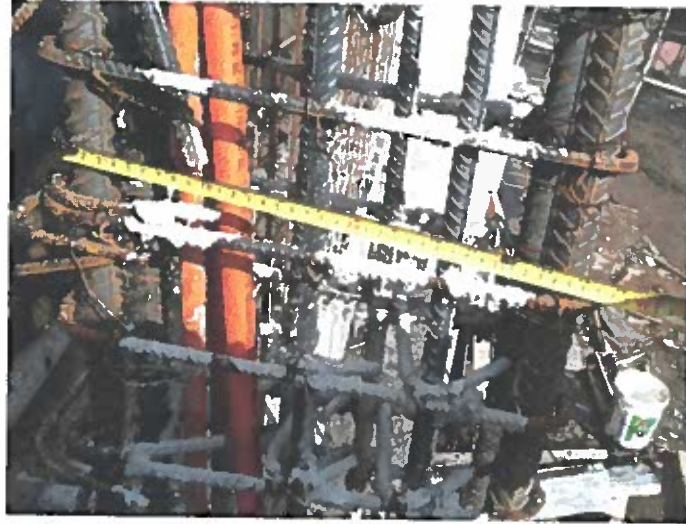
Fotografía 5 Armadura de pilar tipo "P7" ubicado en la intersección de los ejes D' y 1B
