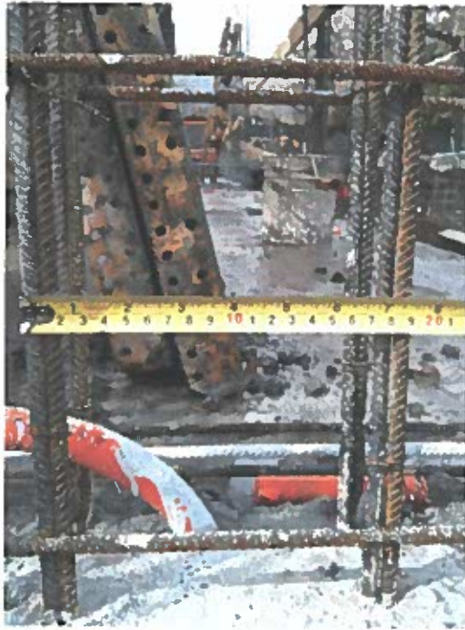
Fotografía 3 Armadura de muro ubicado en eje 1, y entre los ejes A' y B.
